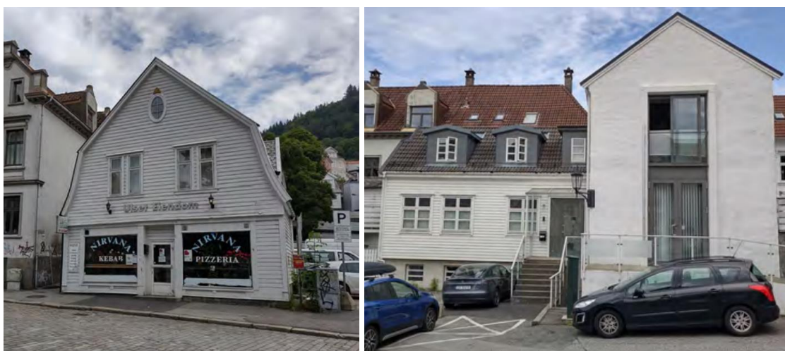
Figur 2-4 Øvregaten 43 på bildet til venstre, 43A på bildet til høyre.
